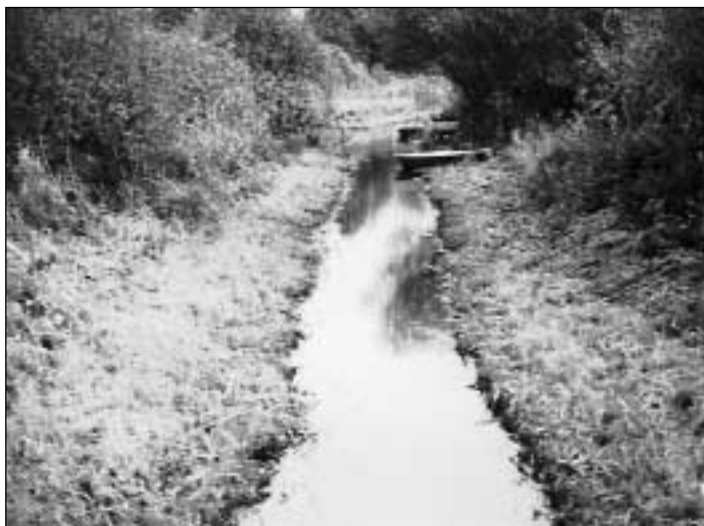
Im Hintergrund: Unerlaubter Stegbau an der Sude
